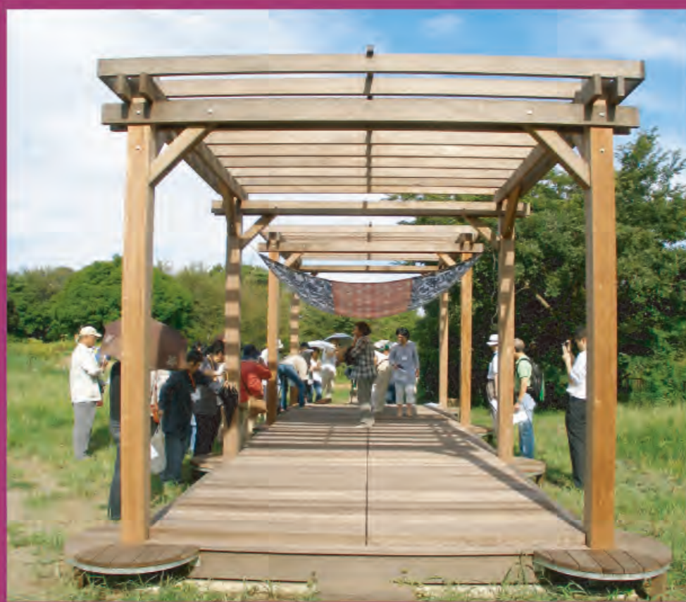
完成した雨だれデッキ
